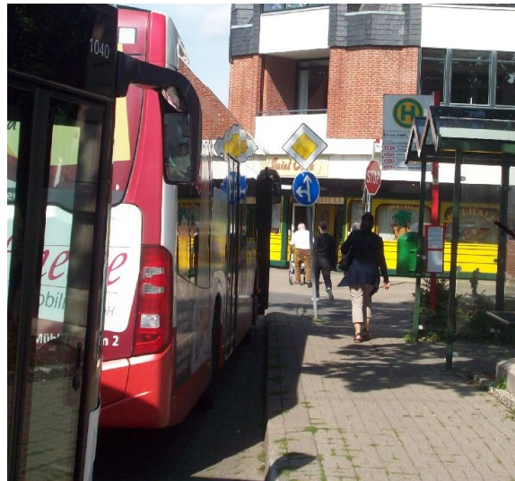
Abb. 3.10: Haltestellen im Stadtgebiet sind nicht barrierefrei (Beispiel: Haltestelle Denkmal)
