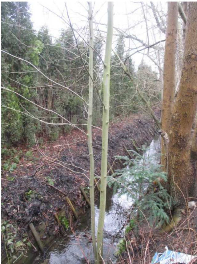
Foto/Abb. 08: Blick nach Osten - Fournier Mühlenbach
