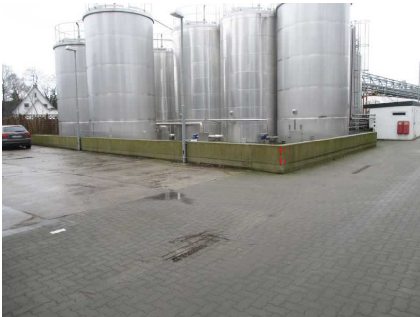
Foto/Abb. 02: Blick nach Südwesten auf Hochbehälter Tanklager
